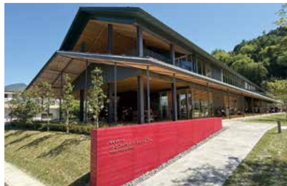
つるフィールド・ミュージアム(2025年4月竣工)
