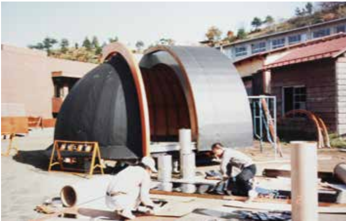
自然科学棟の上の天体ドーム工事
