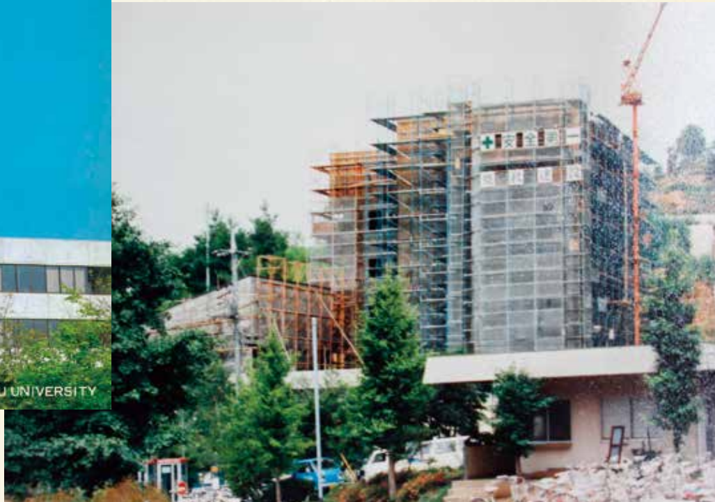
■ 1982(昭和57)年 自然科学棟 建設中 (写真提供:名誉教授 森江晃三先生)
