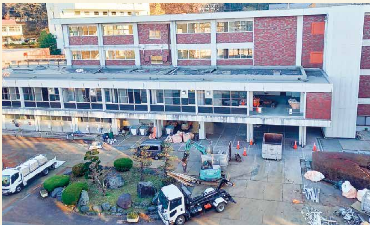
■ 2025(令和7)年 1号館改修工事
